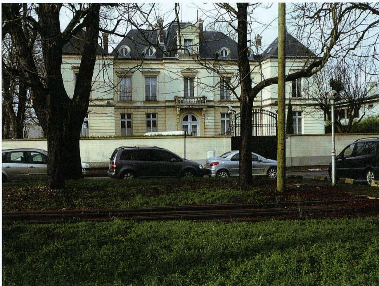
La sous-préfecture, coupée de la ville par une voie de chemin de fer .
