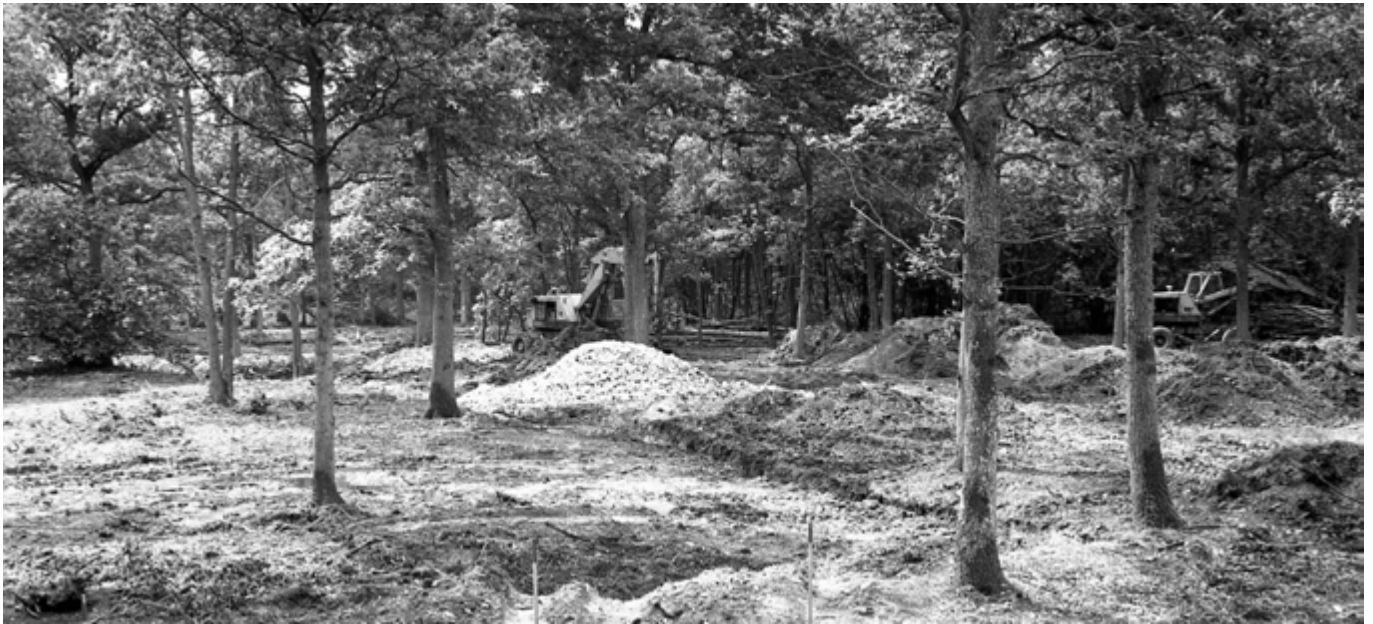
Défrichage et drainage
