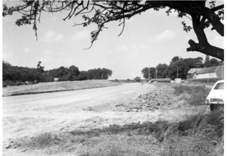
1970, début des travaux devant la ferme du Bois-Briard
