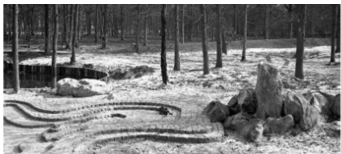
Réalisation du bassin en pavés
