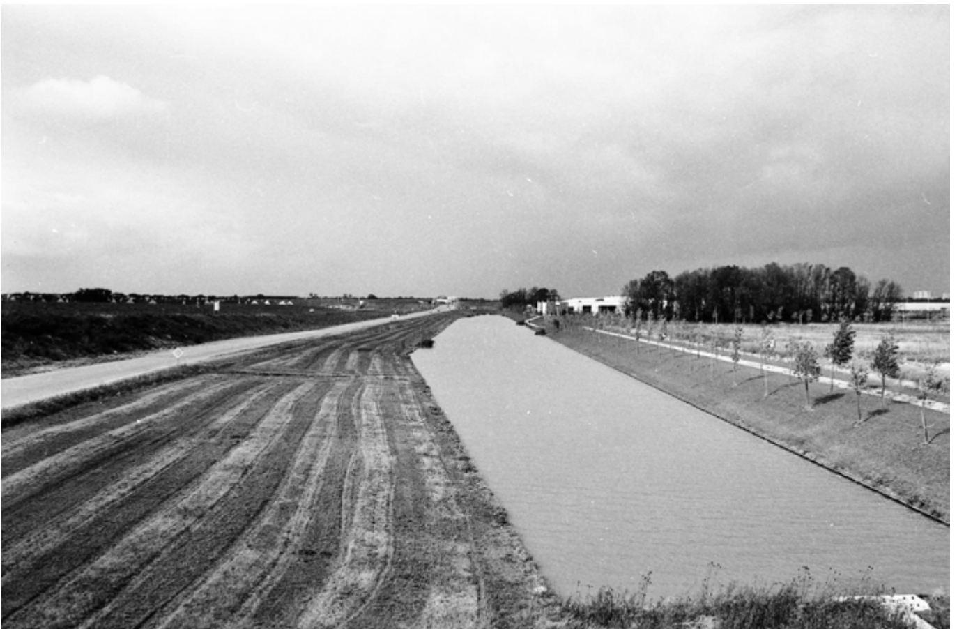
1974, la pente douce entre la voie et le canal de Saint Guénault (Très difficile à faire admettre aux ingénieurs de la DDE et pourtant sans elle le plan d'eau serait invisible).
