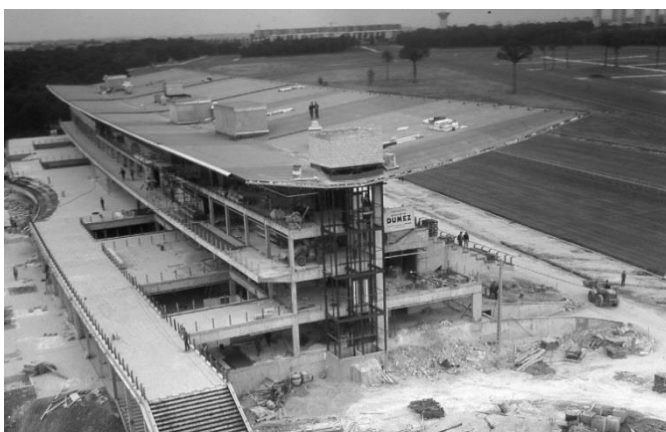
construction des tribunes de l'hippodrome
