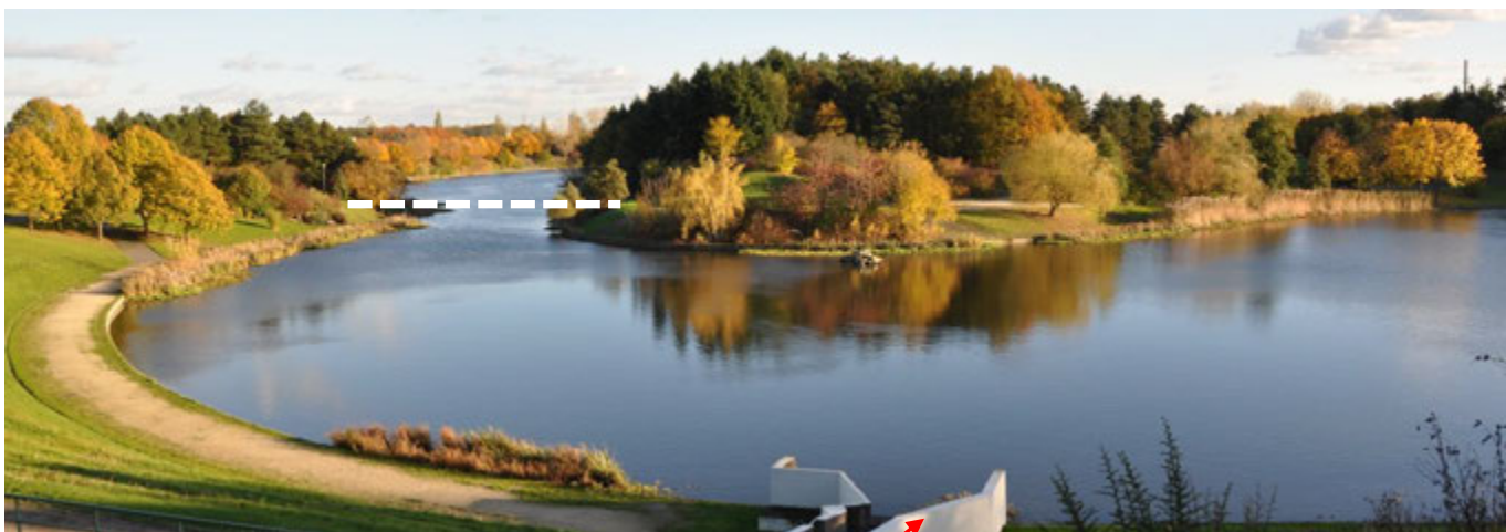
La partie médiane, le déversoir et le secteur Ouest
