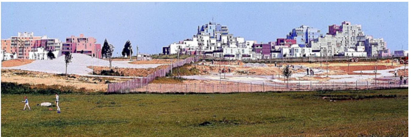
1977, construction des buttes pavées
