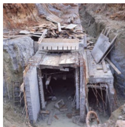
Les deux conduits d'eaux pluviales et usées sous le parc
