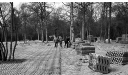
Pose de l'Over-Green sur le grand parking
