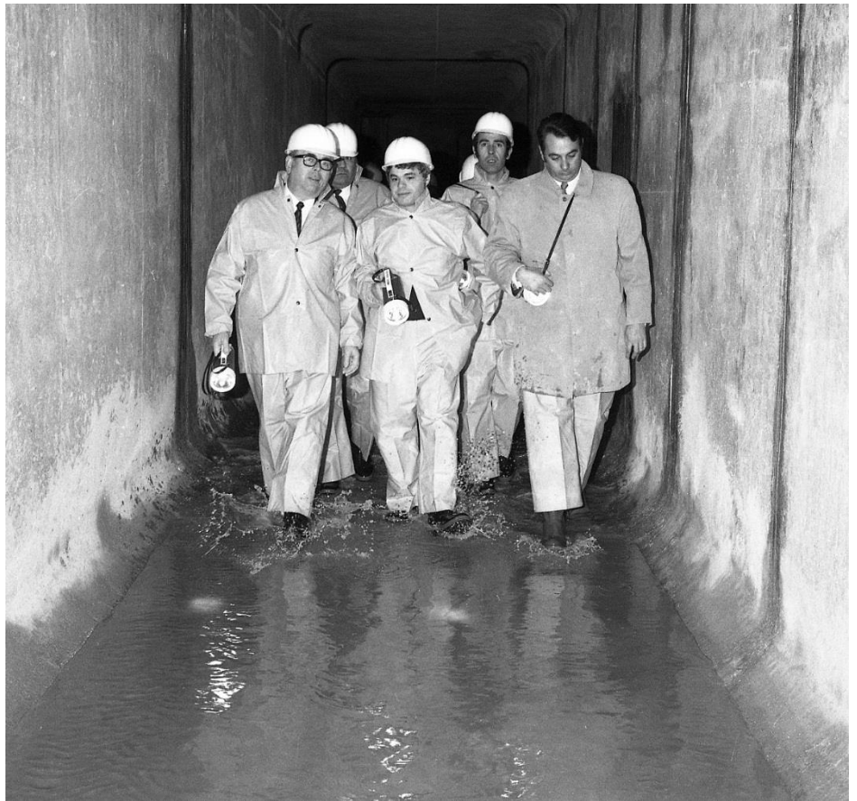
1972, le collecteur principal d'eaux pluviales : sous le parc Henri Fabre
