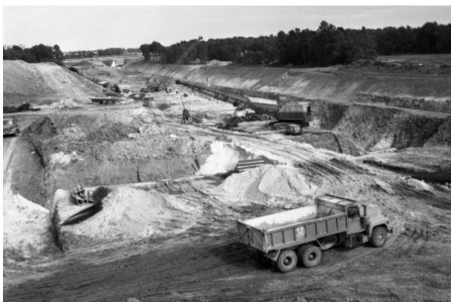
1973 la tranchée SNCF au niveau de la gare Évry-Courcouronnes
