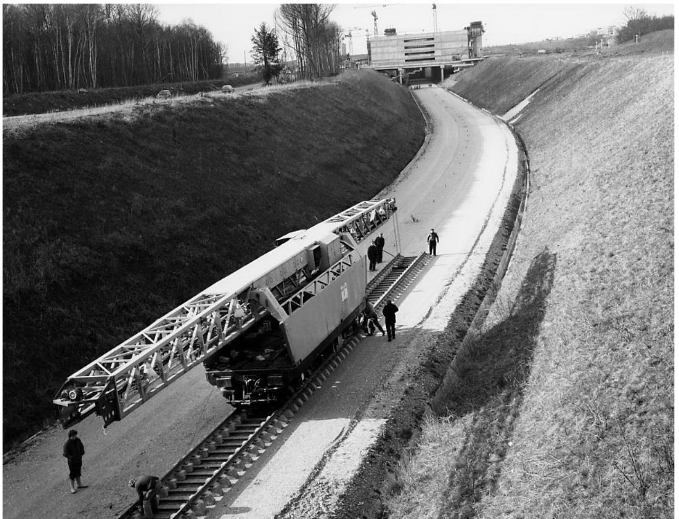
1975, la tranchée SNCF au niveau d'Évry-centre, vue vers l'Ouest depuis le pont du Bd de France
