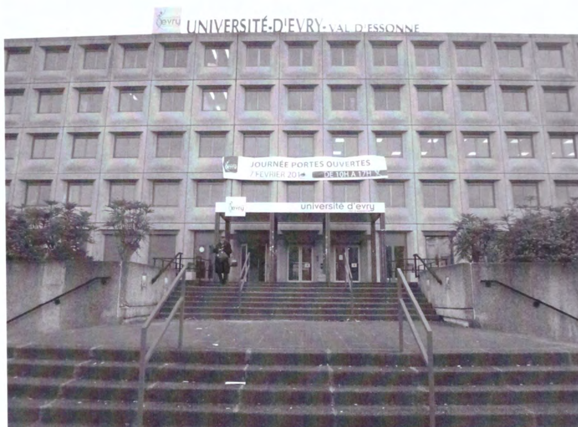
Février 2015 Immeuble Ile-de-France
