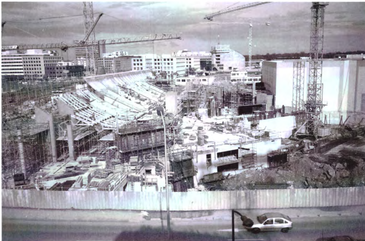
Avril 1993 Chantier du bâtiment de l'université 1er cycle
