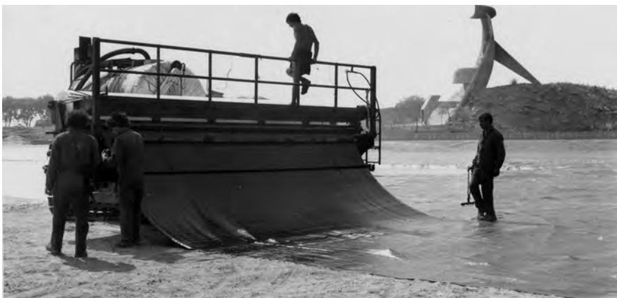
Etanchéité du lac de Courcouronnes le 19 août 1976
