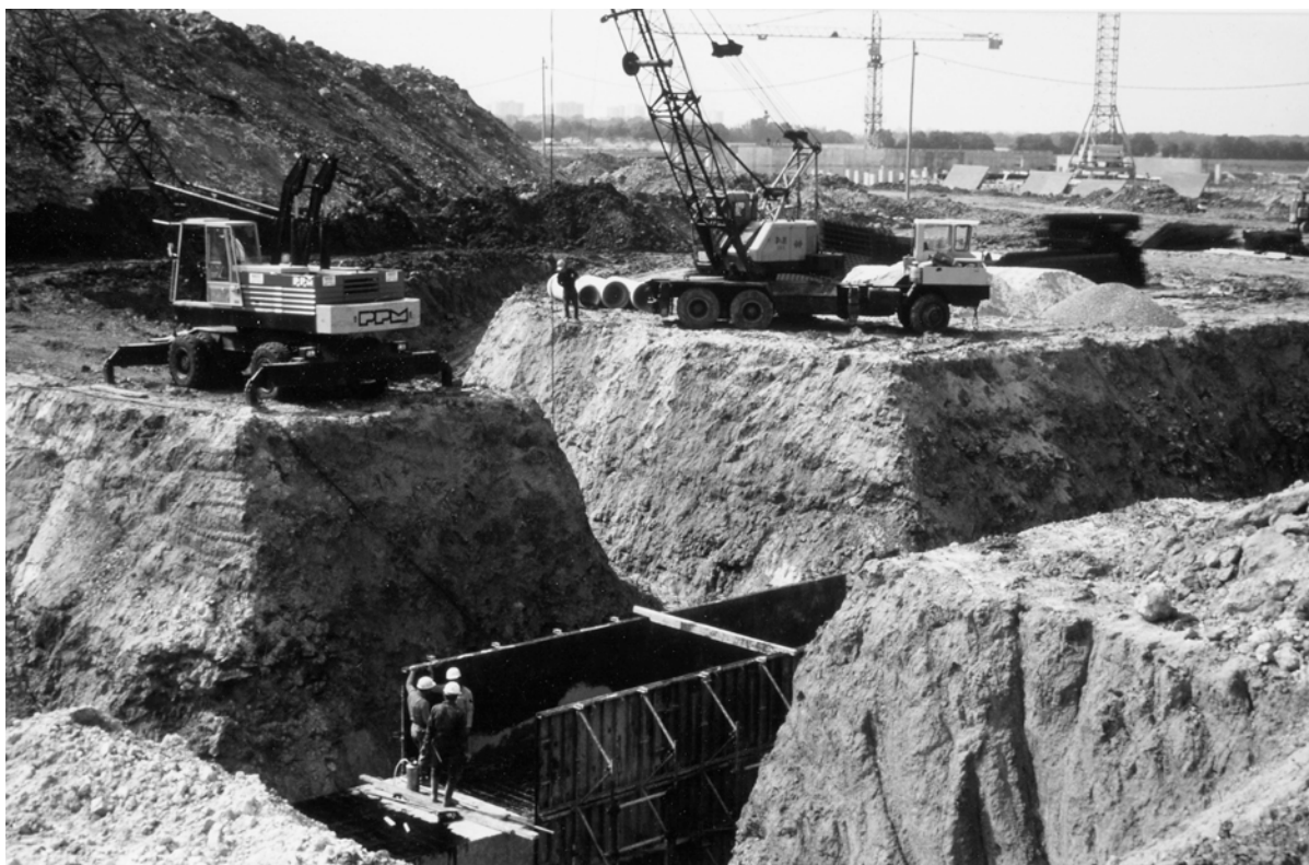
La galerie technique sous le cours Blaise Pascal en juin 1973 (au fond: début du chantier de l' Agora et du centre commercial)
