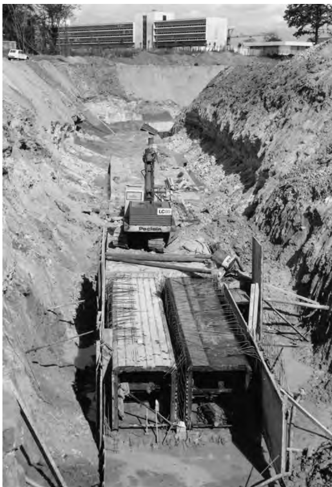
Collecteur principal pour les eaux pluviales, passage sous la SNCF au sud du parc Henri Fabre, le 14 septembre 1971
