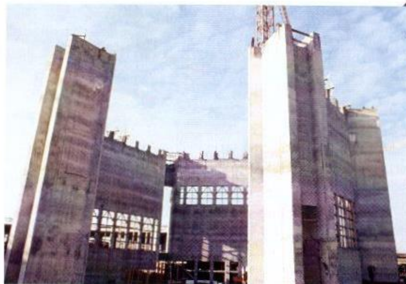
PLANQUETTE : 1973. Construction de l'hexagone [grande salle].
