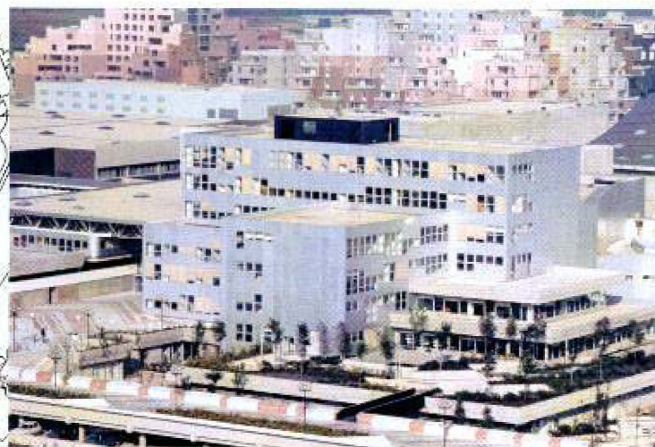
PLANQUETTE : vue sur le jardin de la bibliothèque et sur la gauche l'entrée sur la grand place (16). Le bloc noir sur le toit est l'hexagone theatre (15). Au loin le quartier coloré des pyramides.
