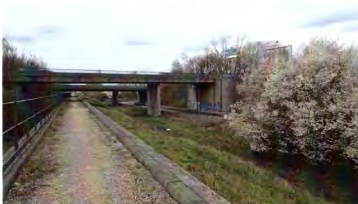
Aqueduc de la Vanne sous la Francilienne
