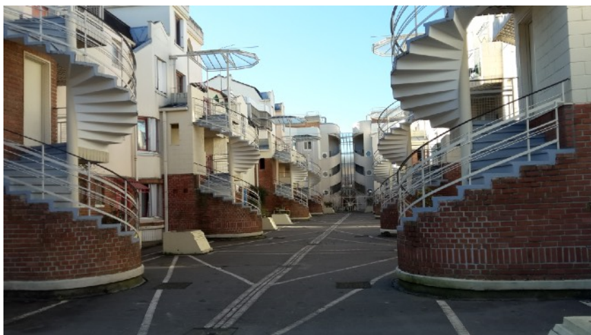
Architecture urbaine des années 1970. Les Ombrelles. Arch.Sarfati
